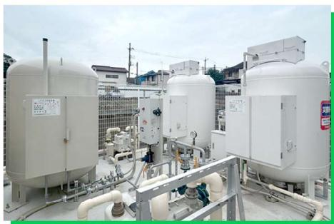
非常時の電気や熱のエネルギー源には、LPG（液化プロパンガス）を採用。これにより、停電してもLPガスを使って電力を生み出し、空調なども3日間は安定して稼働できる体制を整えています。
